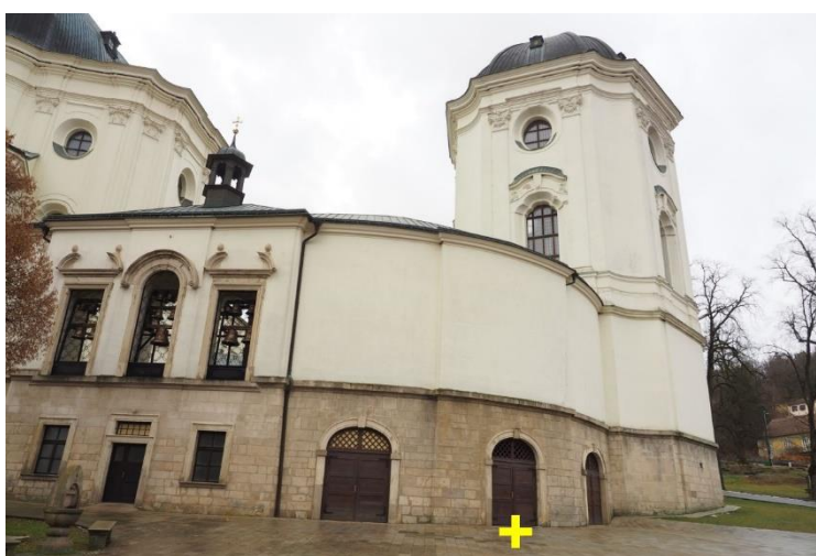
31.12.2021: Vchod po Podzemního systémku pod jižním ambitem na křtinském náměstí.
