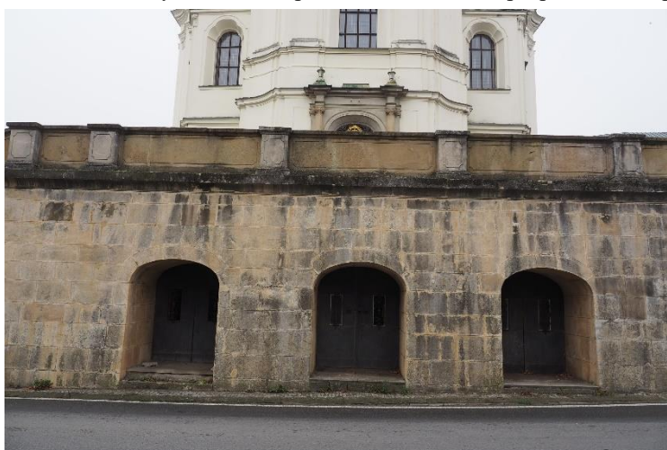
30.10.2022: Sklepení u silnice pod nástupní teráskou schodiště ke chrámu Panny Marie.
