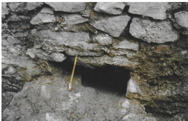
Objevný otvor do Chodby pod severním ambitem (2005).
