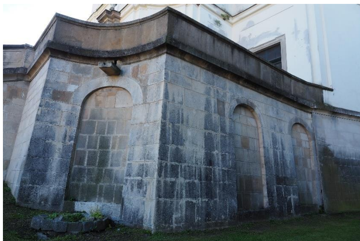
2.9.2022: Zazděné vchody do kostnice v terase schodiště při pohledu od náměstí.
