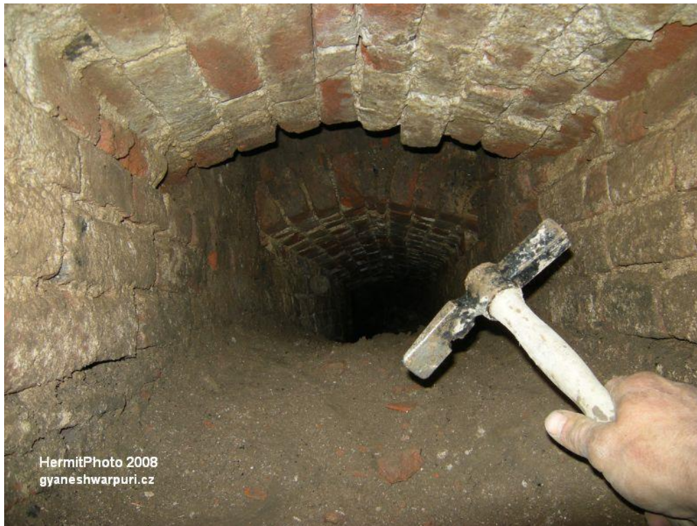
Ucpávka pod vertikální šachtou. Chodba pod jižním ambitem (2008)
