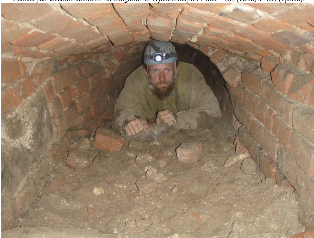
Vstupní chodba do podzemního systémku pod jižním ambitem. M. Gyaneshwarpuri (2008).
