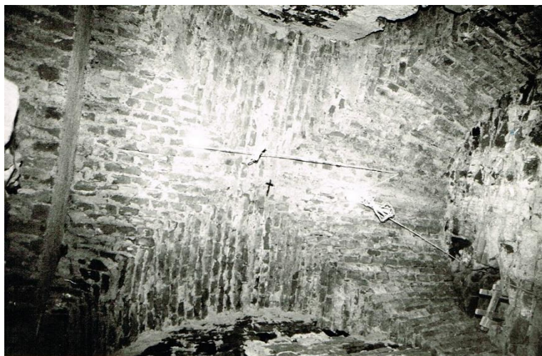
Stropní klenba v Kryptě pod věží (1991).
