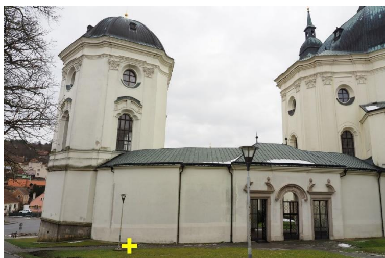
31.12.2021: Vchod po Chodby pod severním ambitem směrem k faře.
